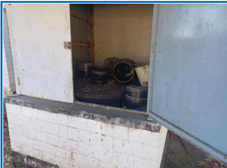
Abbildung 10: (gesonderte Ausweisung im Bereich vorhabenbezogener BPlan Nr. 15 [U21]), ehemaliges Altöllager als nördlicher Anbau des Hauptgebäudes II, mit vorhandenem ca. 1.000 l Sammelbehälter (Metallfass) und Altölrückständen (Blickrichtung Süd), Bereich Bohransatzpunkte BS 1 - BS 3 (Quelle: Ortsbegehung b<sup>4</sup>c mit Herrn Henkel am 03.03.2022)
