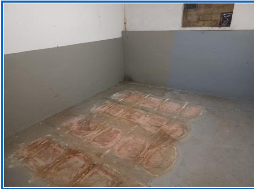
Abbildung 10: ehemaliges Heizöllager für 4 x 2.000 l, Stellraum mit Abdichtungen (Anstrich) versehen, unterhalb der Stellflächen der Tanks kein Anstrich, Tanks rückgebaut (Blickrichtung Nord) (Quelle: Ortsbegehung b<sup>4</sup>c mit Herrn Henkel am 03.03.2022)
