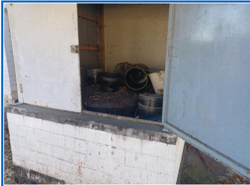
Abbildung 12: **gesonderte Ausweisung im Bereich vorhabenbezogener BPlan Nr. 15 [U21]**, ehemaliges Altöllager als nördlicher Anbau des Hauptgebäudes II, mit vorhandenem ca. 1.000 l Sammelbehälter (Metallfass) und Altölresten (Blickrichtung Süd) (Quelle: Ortsbegehung b<sup>4</sup>c mit Herrn Henkel am 03.03.2022)
